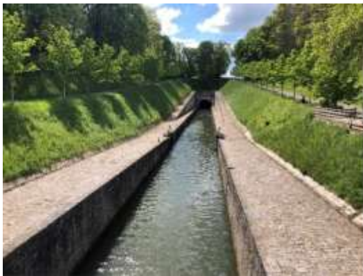
Le canal-tunnel de Saint-Aubin
